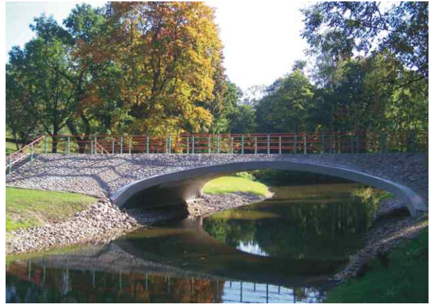
SuperCor® konstrukcijų pėsčiųjų tiltas per Dotnuvėlę iš Kėdainių centrinio parko, minareto link. Konstrukcijos plotis 14,11m, aukštis- 3,48m. Statybos metai- 2008 m. Rangovas UAB „Kėdainių statyba“, subrangovas UAB „ViaCon Statyba“.
