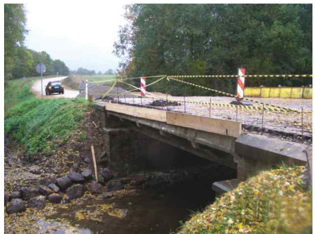
Seno akmenų-gelžbetonio tilto per Kruoją, kelyje Lygūmai-Nasiai (Pakruojo r.) Platinimas prijungiant SuperCor® konstrukciją. Rangovas: VĮ Šiaulių regiono keliai.
