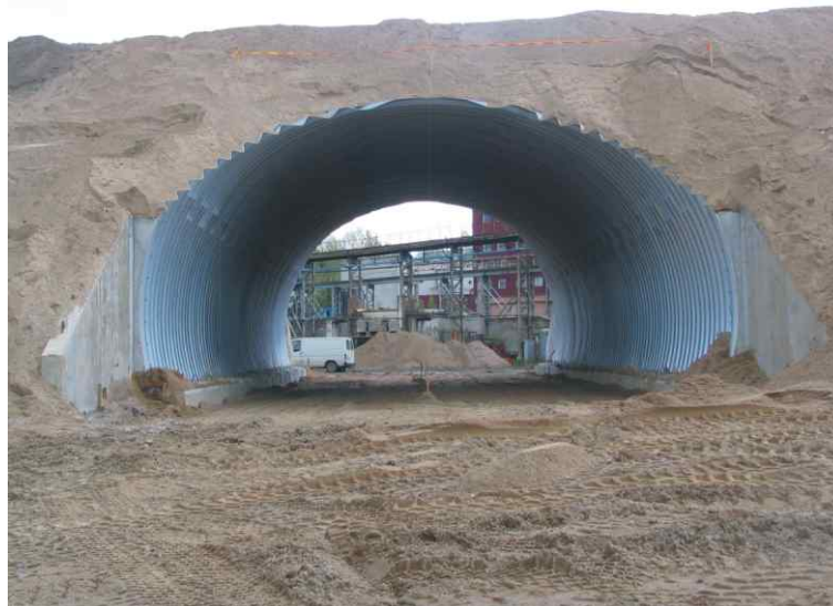
Tolygus grunto užpylimas aplink konstrukciją
