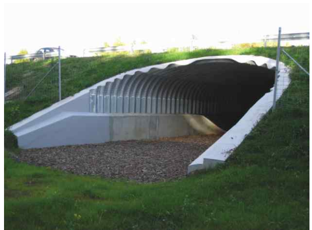
Gyvūnų pragina A2 kelyje Vilnius-Panevėžys 21 kilometre. Konstrukcija SC-32B.
