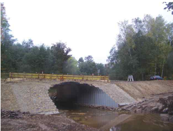
Seno akmenų-gelžbetonio tilto per Kruoją, kelyje Lygūmai-Nasiai (Pakruojo r.) Platinimas prijungiant SuperCor® konstrukciją. Rangovas: VĮ Šiaulių regiono keliai.
