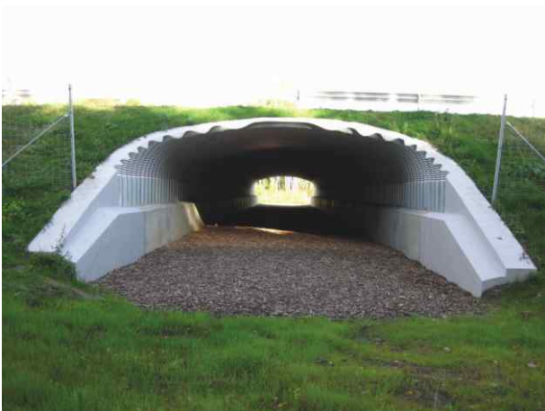
Gyvūnų pragina A2 kelyje Vilnius-Panevėžys 21 kilometre. Konstrukcija SC-32B.
