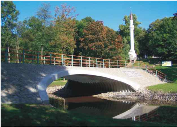
SuperCor® konstrukcijų pėsčiųjų tiltas per Dotnuvėlę iš Kėdainių centrinio parko, minareto link. Konstrukcijos plotis 14,11m, aukštis- 3,48m. Statybos metai- 2008 m. Rangovas UAB „Kėdainių statyba“, subrangovas UAB „ViaCon Statyba“.
